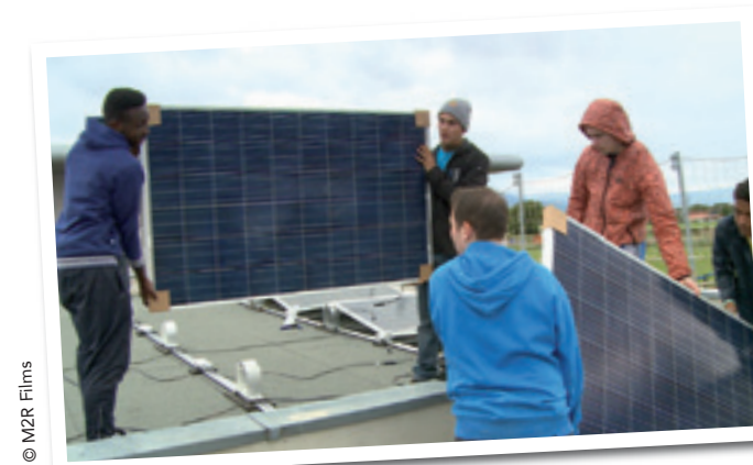
• Installation de panneaux photovoltaïques sur un bâtiment municipal
